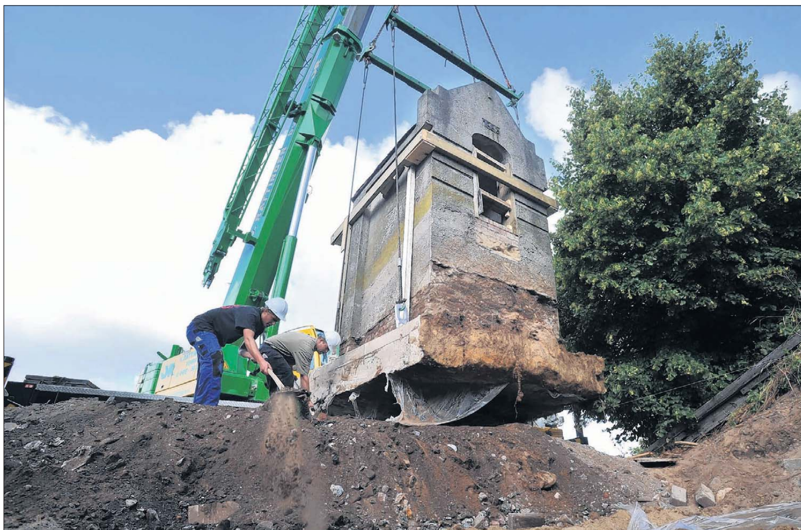
Met een grote takelkraan werd de Sint Anna ten Drieën kapel in Wellerlooi gisteren enkele meters verplaatst.
